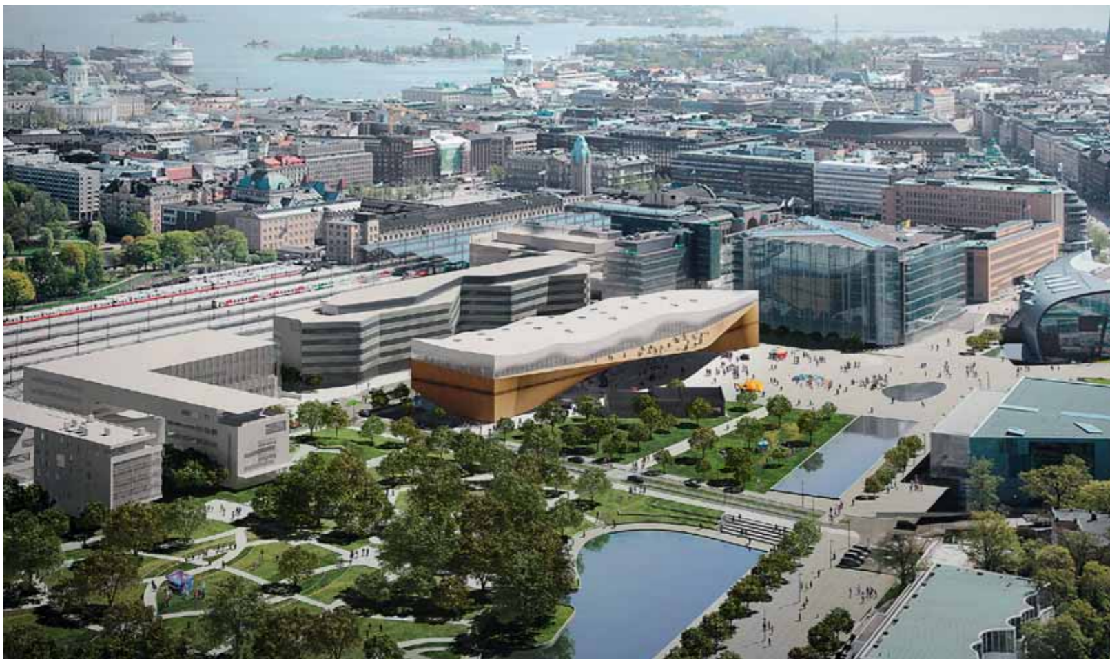
Luftbild des neuen Kulturzentrums von Helsinki: in der Mitte die im Bau befindliche Zentralbibliothek, rechts das Kunstmuseum Kiasma (1998) von Steven Holl, darunter das Haus der Musik (2011) von LPR Architects Abb.: ALA Architects
