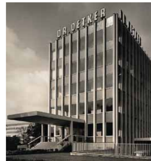
Dr. Oetker-Verwaltungsgebäude in Berlin, 1960/61
