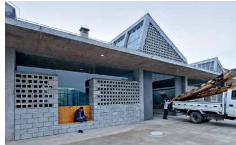
Links: Blick auf die Produktionshalle und das Bürogebäude der Bambusfloß-Werft. Unten: Lagergebäude, in dem die Bambusstämme getrocknet werden.
