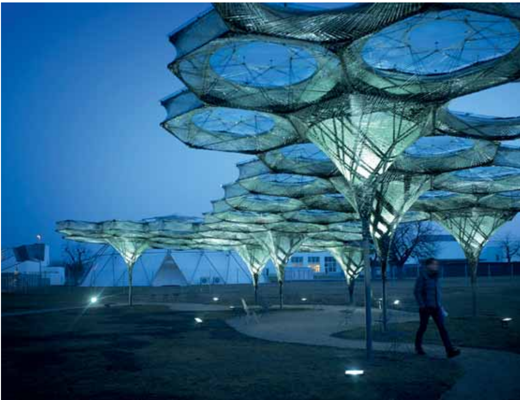
Der „Elytra Filament Pavilion“, ein Projekt des ICD/ITKE der Uni Stuttgart, auf dem Vitra-Campus. Rechts:
