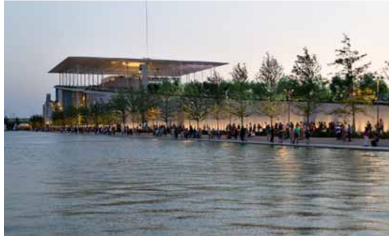
Während man auf der geneigten Parkfläche zur Aussichtsterrasse läuft, gibt es am Kanal eine Promenade zum Eingang von Bibliothek und neuer Staatsoper. Fotos: © SNFCC, Yiorgis Yerolymbos; Plan: © RPBW, 1:5000
