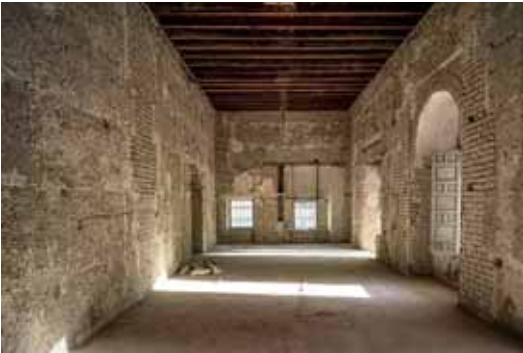
Im Inneren des Komplexes lassen die Architekten die „nackten Knochen“ der Konstruktion sprechen. Rechts
