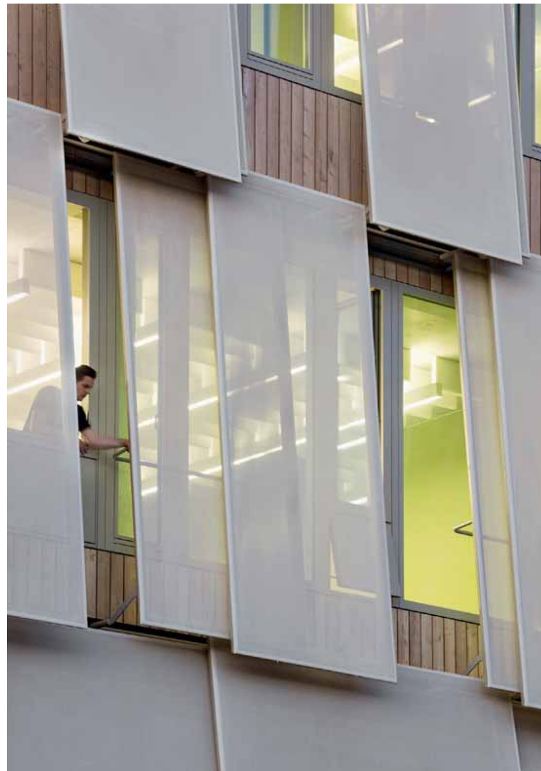
Hand anlegen: Jeder zweite Stahlrahmen kann von den Nutzern zur Seite geschoben werden.
