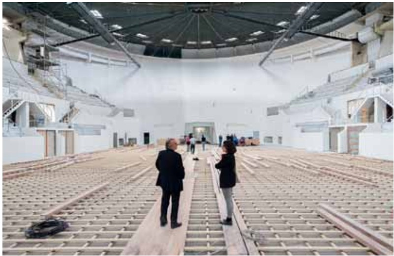
Die Halle wurde weitgehend in ihrer ursprünglichen Gestalt wieder hergerichtet. Links: Die Architekten auf der Baustelle. Der Holzboden wurde vollständig neu eingebaut.
