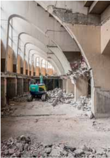
Der äußere Ring wurde deutlich verändert. Man entfernte teilweise die Erschließungsebene im Erdgeschoss. Die Bogenkonstruktion kommt nun mehr zur Geltung. Foto links: Atelier Ferret; Erdgeschoss, Tribünenaufricht und Schnitt im Maßstab 1:750
