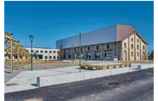
Die Stirnseite mit dem auf den ersten Blick befremdlichen Dachaufbau. Die Bogenfenster wurden teilweise mit Douglasie verkleidet. Kleines Foto: Zugang zum Archiv, links die Pergola mit der Glyzine.
