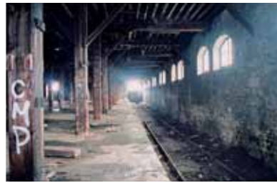
Die alte Lagerhalle der Eisenbahn wurde durch ein Feuer weitgehend zerstört. Beim Bau des Archivs waren nur die Außenmauern vorhanden. Das Innenfoto zeigt das Gebäude mit den Gleisen vor dem Brand. Fotos links und Luftfoto: Robbrecht en Daem
