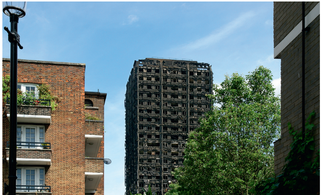
Blick von der Bramley Road auf den ausgebrannten Grenfell Tower Foto: Chiral Jon/CC-BY-2.0/Wikimedia Commons
