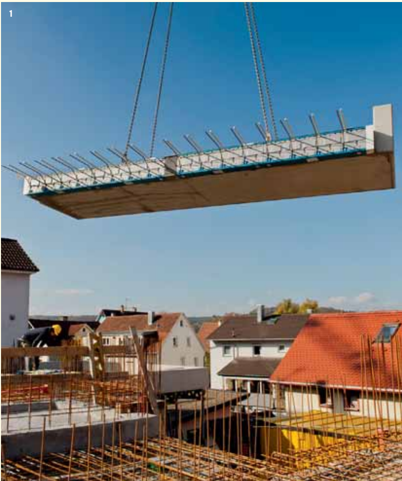
Der Balkon mit einbetoniertem Isokorb XT-Combar wird zum Einbau auf der Baustelle transportiert 1.
