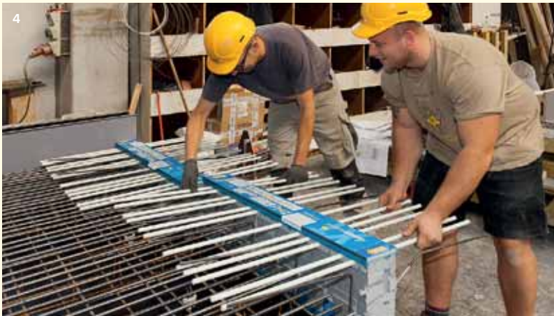
Isokörbe im Einsatz an den Paragon-Apartments in Berlin von GRAFT Architekten 2. Mit seinen eingesetzten Zugstäben aus Glasfaser verbessert der Isokorb XT-Combar die Wärmedämmung um bis zu 30 Prozent 3. Die deutlich kürzeren Stäbe machen den Isokorb XT-Combar kompakter und leichter, was die Handhabung vereinfacht 4.
