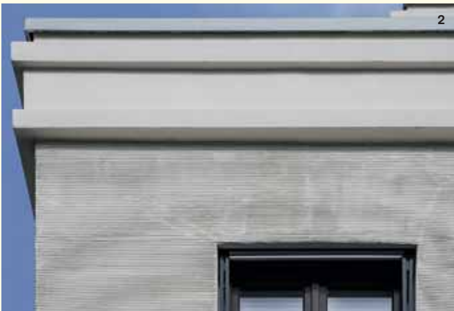
Bei der Kellenwurf-Putztechnik kommt es auf das Können des Handwerkers an 1 . Ziehputz: Alte Putztechnik setzt auch bei modernen Fassaden Akzente 2, 4 .
