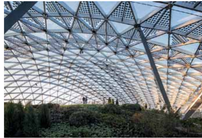
Die Klimahülle überspannt 9000 Quadratmeter und steht auf einem künstlichen Hügel, in den das Konzerthaus eingegraben ist. Schnitt im Maßstab 1:2000
