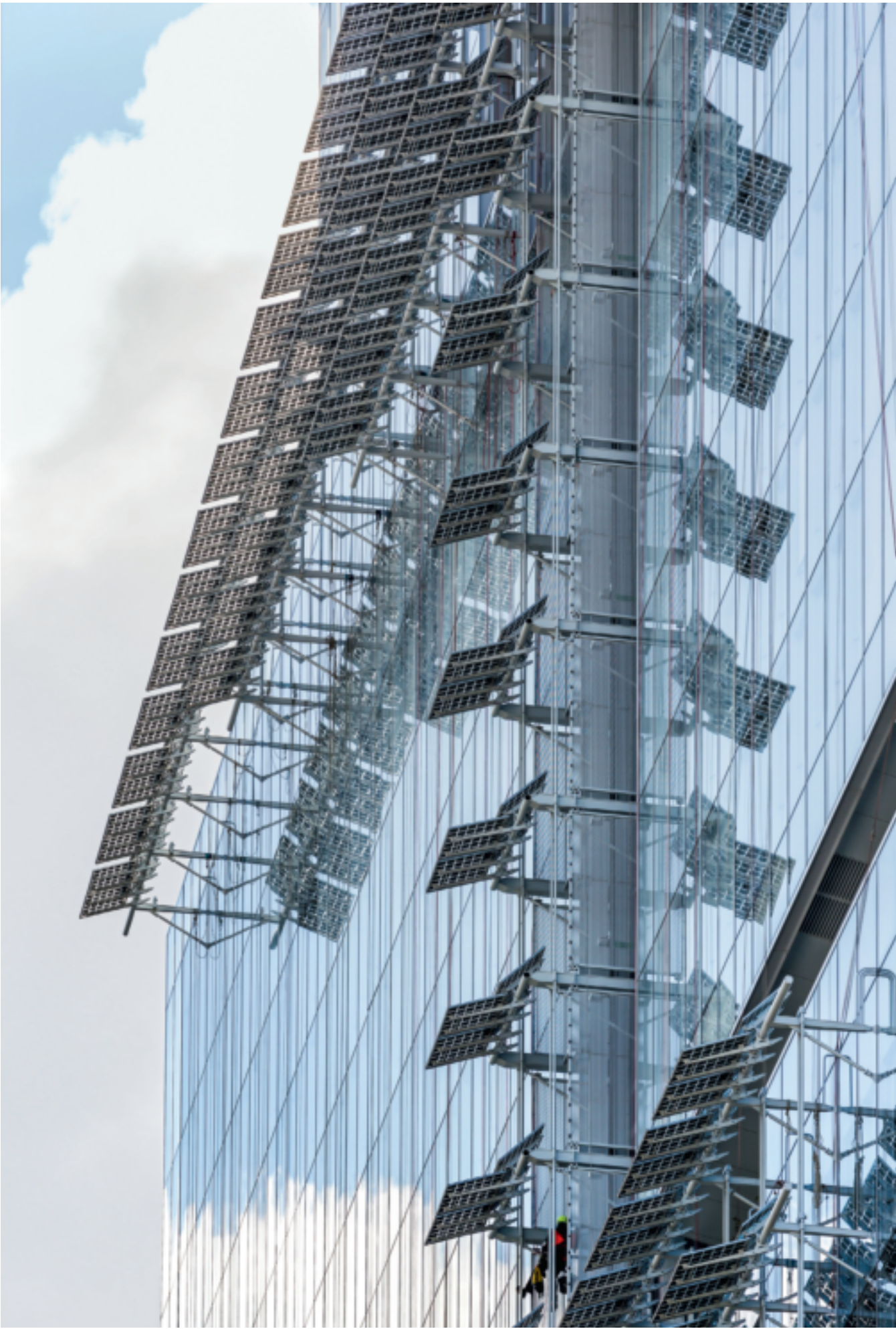
Detailansicht der Ostfassade mit dem Panoramaaufzug und den vorgesetzten Solarpaneelen, die ebenfalls dazu beitragen, den 160 Meter hohen Turm zu untergliedern. Foto: RPBW, Sergio Grazia
