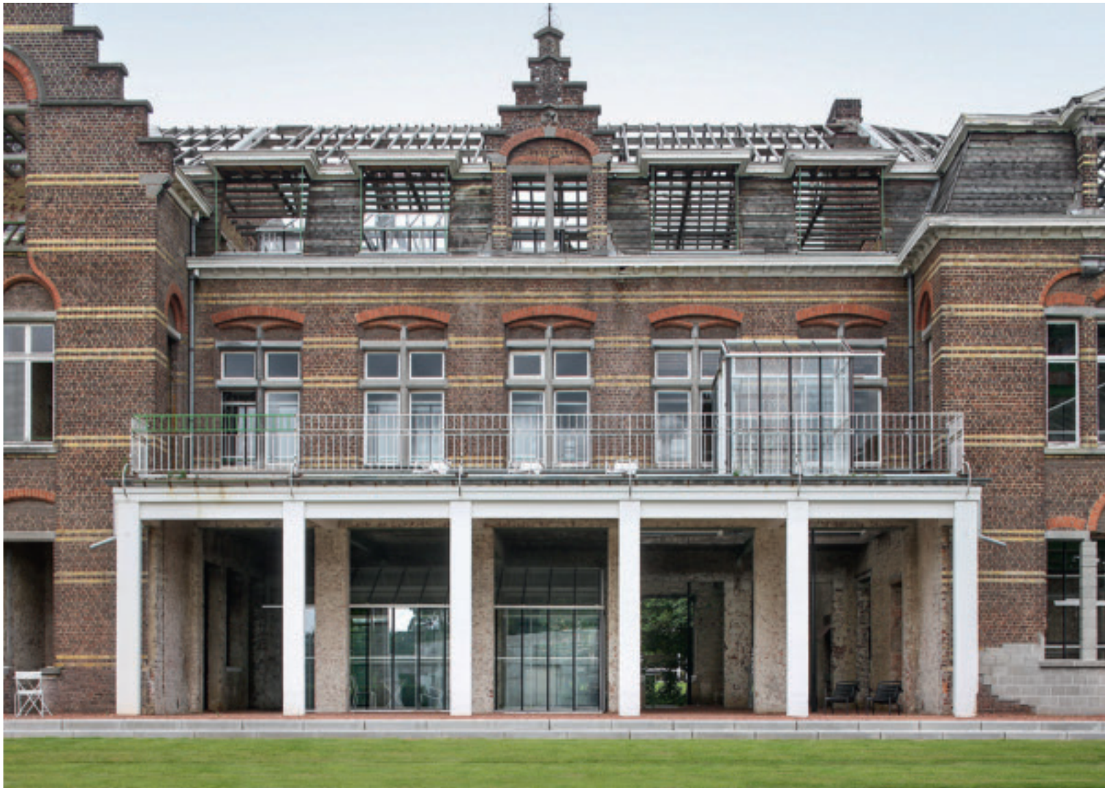
Offenes Haus nach allen Seiten: Fenster und Türen wurden zum Teil entfernt, das Dach bleibt ungedeckt.
