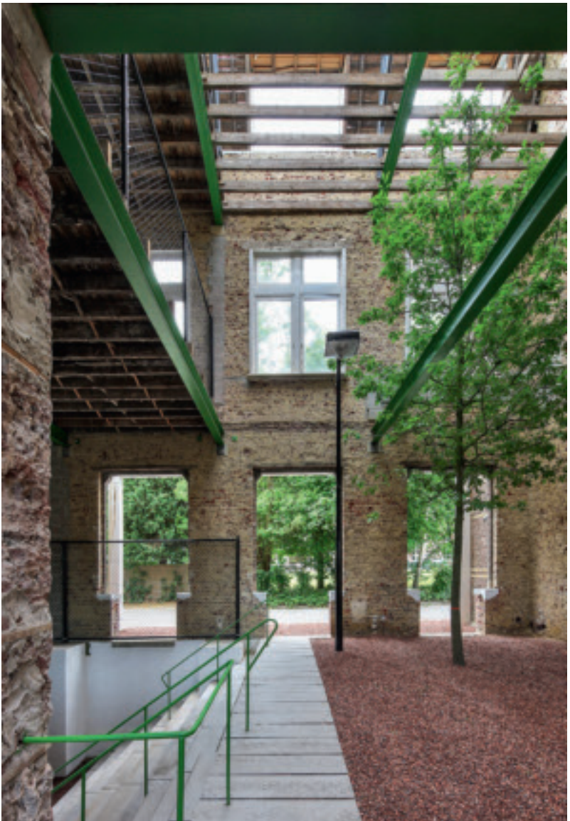
Renovierungsstrategie: Reparaturen werden mit Betonsteinen ausgeführt, die bestehende Stahlkonstruktion sowie neue Geländer grün lackiert. Zudem wurde ein Baum gepflanzt und die weiße Holzloggia auf der Nordseite wiederholt.
