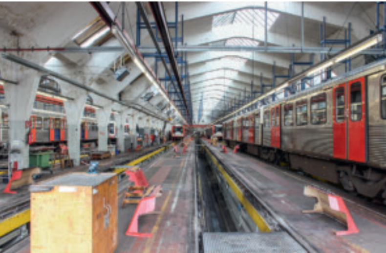
Latenter Modernisierungsdruck bedroht auch die Wagenhalle der U-Bahn-Hauptwerkstatt in Barmbek
