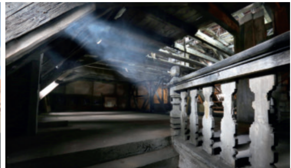
Blick in den dreigeschossigen Dachstuhl des „Grüner-Hauses“ (Dachstuhl errichtet 1711/12), eine im Hochbarock in Cheb typische Konstruktion aus einem stehenden Stuhl mit diagonalen Windverstreben in der unteren Etage und zwei stützenfreien, liegenden Stühlen in den oberen Etagen. Links: Blick aus einer Schleppgaube der zweiten Dach-Etage des „Grüner-Hauses“ auf den Marktplatz. Fotos: Stiftungsfonds Historisches Eger
