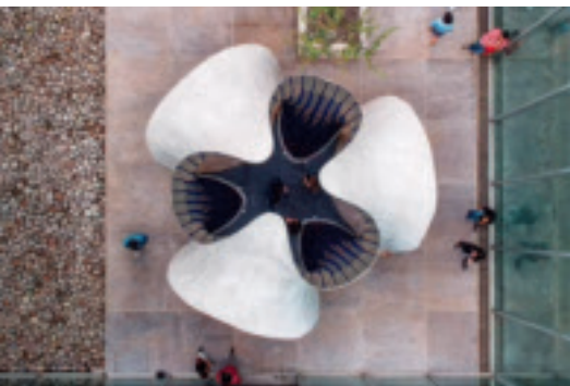
Schalung einfach stricken: Die Betonschale „KnitCandela“ im Museum MUAC in Mexiko-Stadt, eine Hommage an den Schalenbauer Felix Candela, ist eine Kooperation der Block Research Group, ETH Zürich, mit Zaha Hadid Architects. Fotos: Maria Verhulst (großes Foto); Lex Reiter (links); Leo Bieling (rechts)
