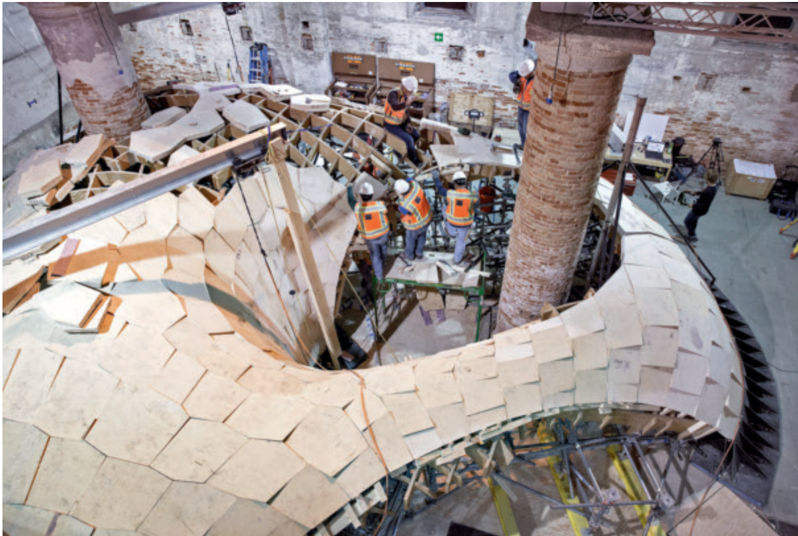
Eine Gewölbeschale aus 399 Kalksteinblöcken, die ohne mechanische Verbindung oder Mörtel verbaut wurden. Was ausgesprochen analog daher kommt, ist aber nur mithilfe hochpräziser, digitaler Berechnungs- und Vorfertigungsprozesse möglich. „Armadillo Vault“ der Block Research Group, ETH Zürich, auf der Architekturbiennale Venedig 2016 Fotos: Anna Maragkoudaki (oben); David Escobedo
