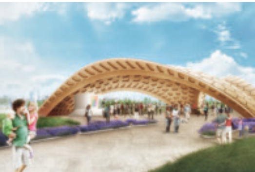
Der „Bionische Holzpavillon“ wird aus 400 hohlen Kassetten unterschiedlicher Größe bestehen, die Roboter aus Platten und Balken vorfertigen. Foto und Renderings: ICD/ITKE Universität Stuttgart
