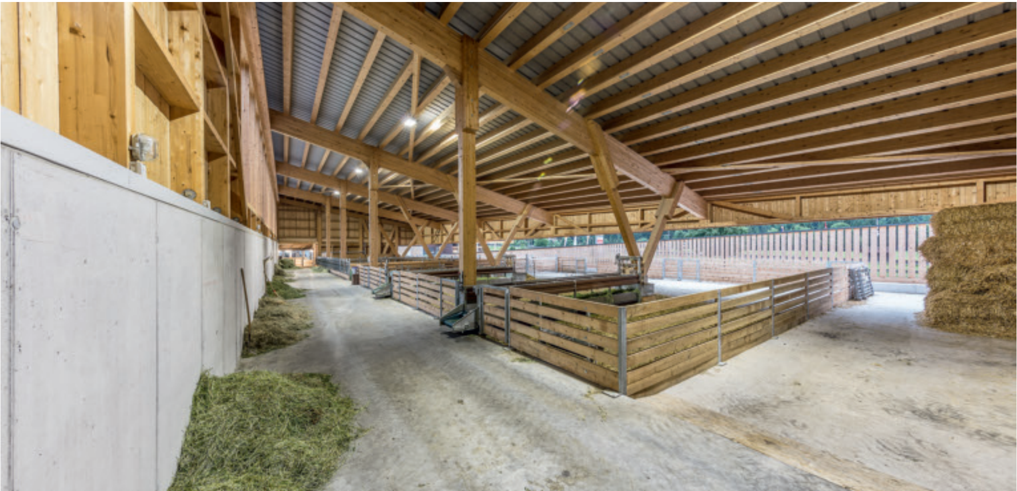
Liegefläche der Schafe und, weiter hinten, der Kühe. An der Wand links verläuft das Fensterband, am Stallende ist die Verbindung zum Melkstand im alten Stall.
