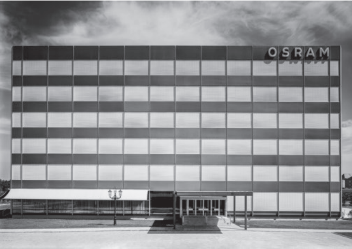
Der quadratische Solitär mit vorgehängter Leichtmetallfassade war für 850 Mitarbeiter konzipiert. Südseite mit Haupteingang und Vordach. Als Sonnenschutz dienten außenliegende Jalousien.
