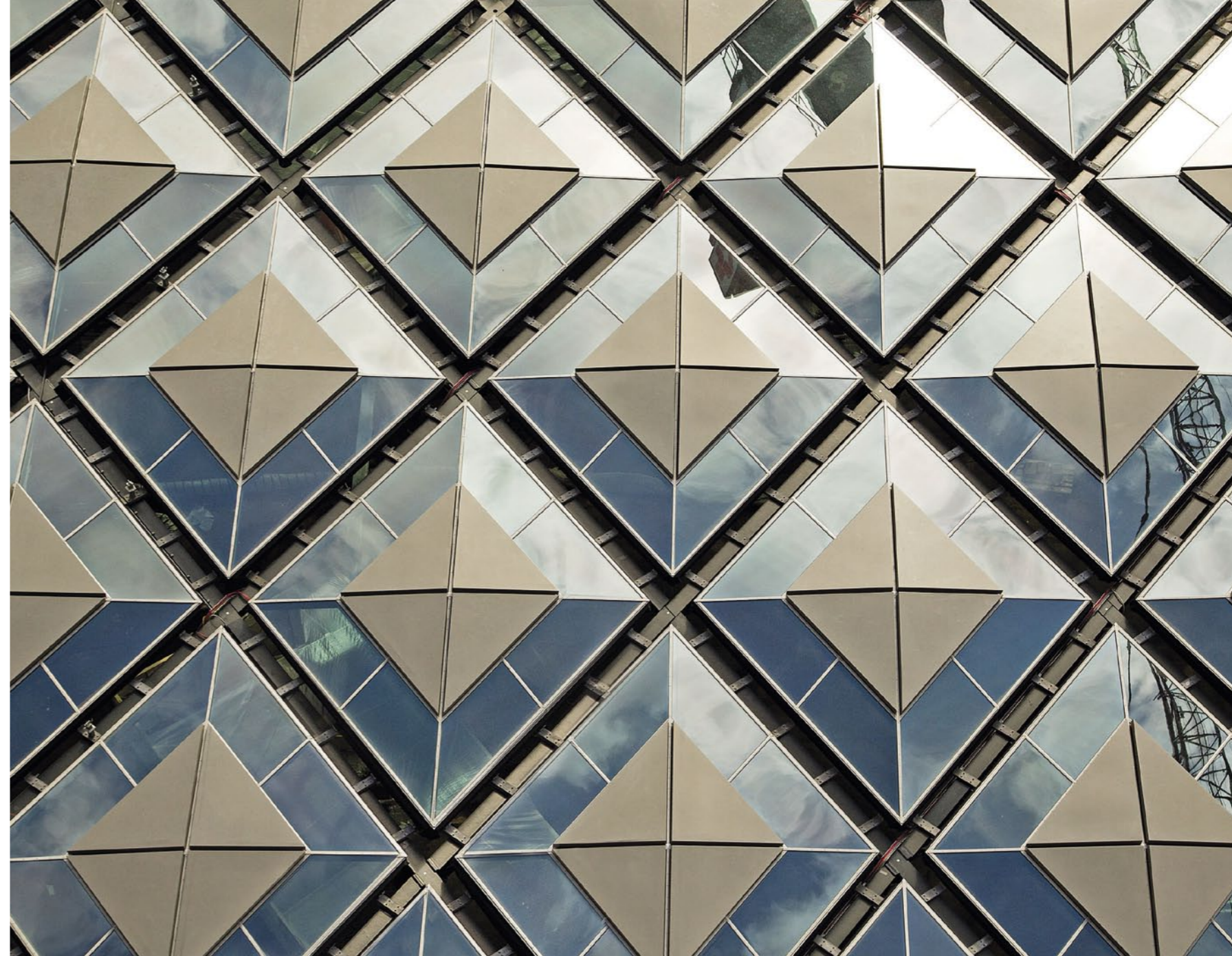
Zentralbahnhof Den Haag – 11.000 m 2 Dachfläche mit Rauch- und Wärmeabzugsanlagen
