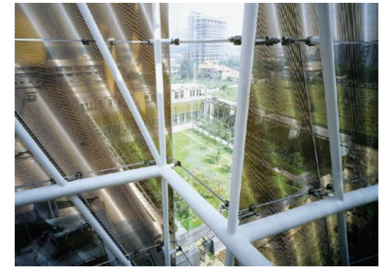
Hauptfront mit zweigeschossiger „Sockelfassade“. Oben: Goldfarben serigrafiertes Glas verkleidet den Büroturm.
