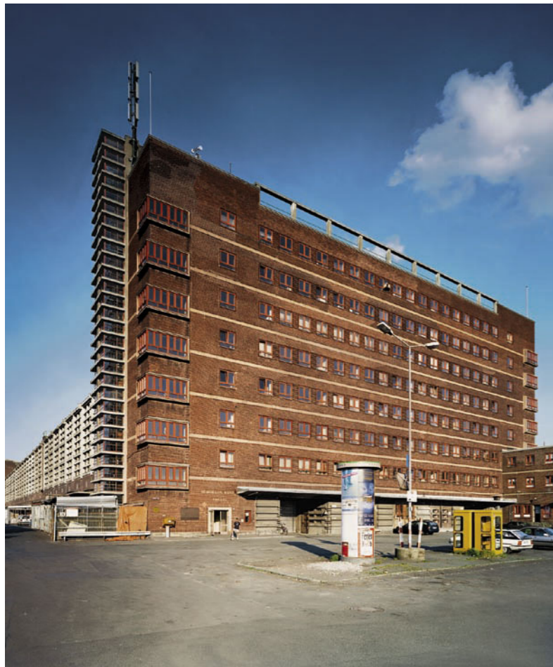
Die eigentliche Markthalle ist 220 m lang, 51 m breit und 23,5 m hoch. In den neugeschossigen Kopfbauten befinden sich Büros und das Kühlhaus. Die imposante Ansicht von der Sonnemannstraße wird auch mit der EZB unverstellt bleiben. Alle drei Preisträger schlagen Hochhäuser an der Uferseite vor.
