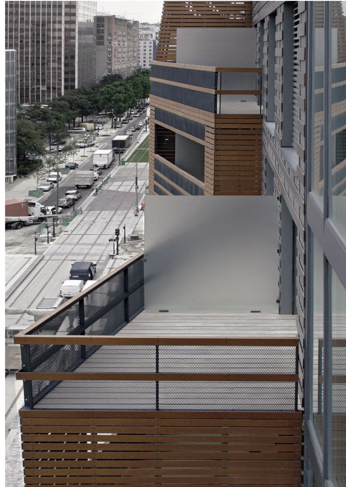
Blick auf die Route des Petits Ponts mit der Tram-Haltestelle „Delphine Seyrig“. Die vorgehängten Balkone sind mit witterungsbeständigen Hochdrucklaminat-Paneeelen verkleidet.
