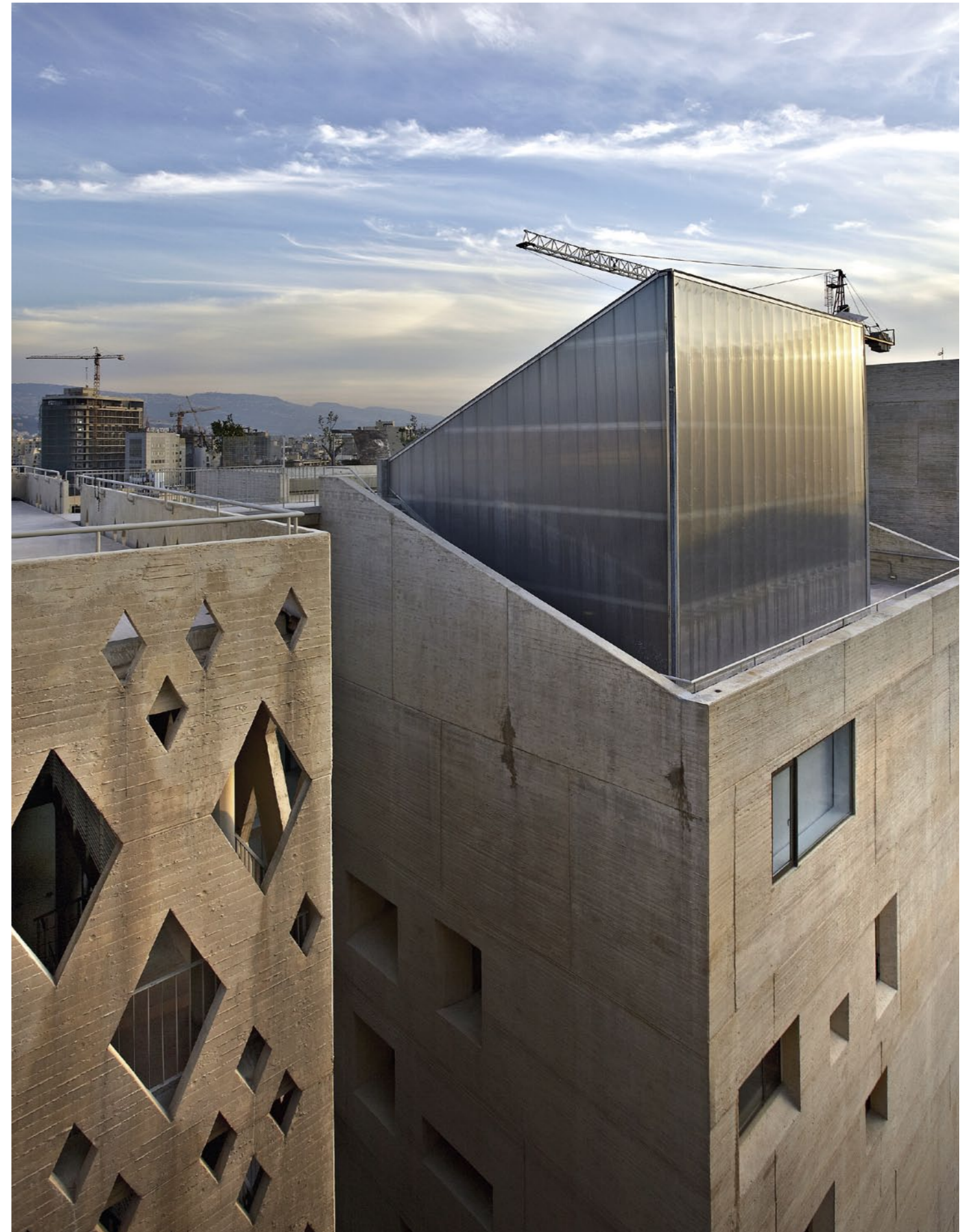
Die Betonfassade – mal vorgesetzte Hülle, mal massiv Wand
