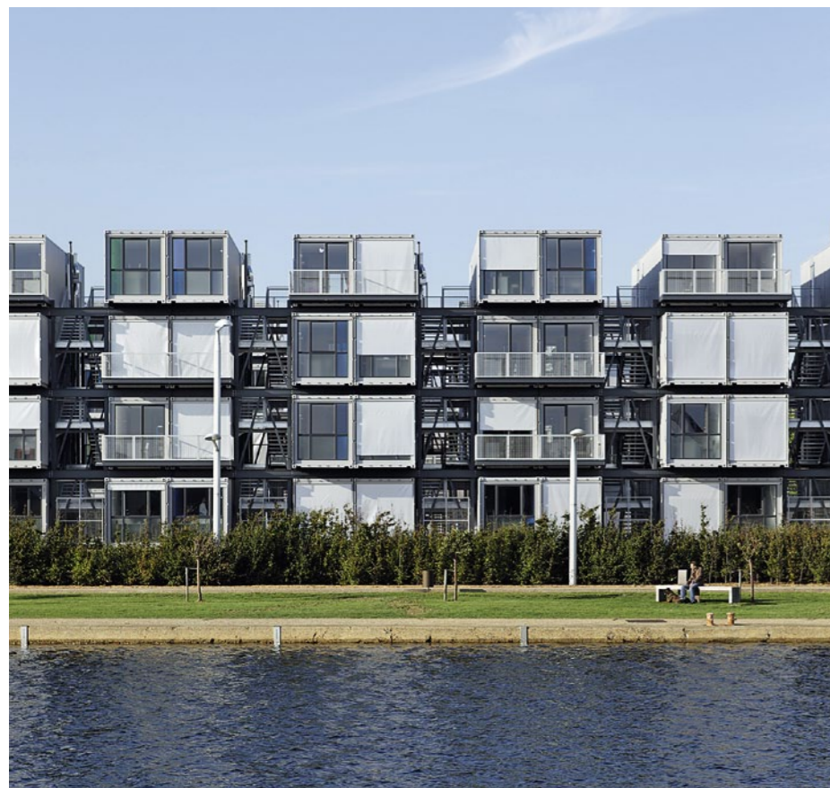
Ansicht vom Quai im Süden. Rechts: Im Doppelcontainer liegt die Wohnung des Hausmeisters. Problematisch ist die große Anzahl an Treppen.
