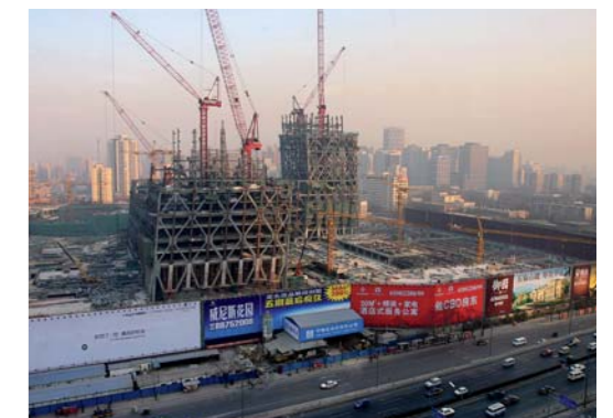
Die Fotos entstanden Mitte Januar. In der Bauphase ist die tragende Konstruktion an den Fassaden der zwei Türme mit ihren unterschiedlichen Verstrebungen gut ablesbar.
