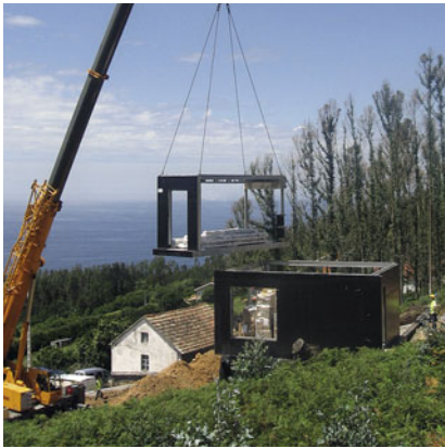
Die Tiefe der 7 Meter langen und 3,50 Meter hohen Module beträgt maximal 3,20 Meter. Mehr hätte sich nicht transportieren lassen.
