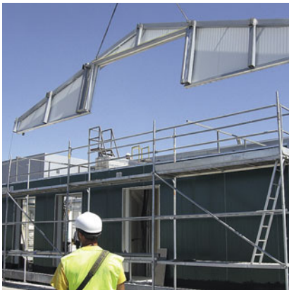
Die Vorfertigung in der Fabrik bot auch insofern Vorteile, als es in Cedeira sehr häufig regnet. Vor dem Transport fand ein Probeaufbau statt.
