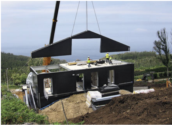
Auf die Umfassungswände der bereits vorher von einem anderen Konstrukteur erbauten Garage wurden die Module des kleinen Hauses aufgesetzt.
