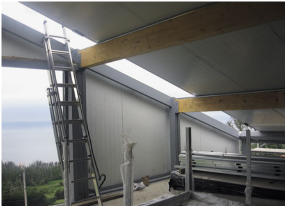
Der Bauherr wünschte sich eine sichtbare Holzbalkenkonstruktion für das Dach. Da nur die Giebelwände vorgefertigt waren, ließ sich das Dach relativ traditionell konstruieren.
