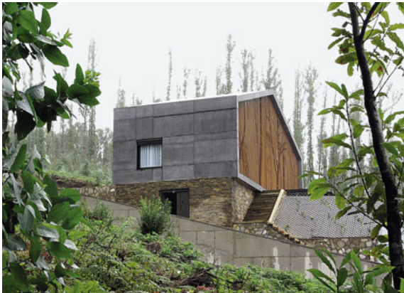
Schmalseiten und Dach sind mit zementgebundenen Holzspanplatten verkleidet. Im Farbton ähneln sie dem traditionell verwendeten Eukalyptusholz.
