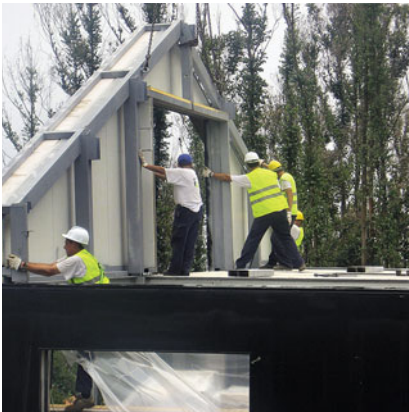
Die Giebel wurden als eigenständige Elemente gefertigt. Theoretisch könnte das Haus um weitere Module aufgestockt werden.
