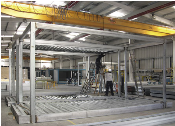
Die Module sind als zusammengeschweißte Käfige aus galvanisierten Stahlrohren ausgeführt. Der Boden besteht aus einem Trapezblech, das dann aufbetoniert wurde.
