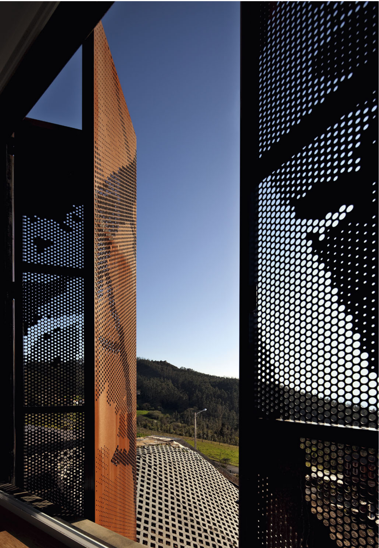
Der perforierte Sonnenschutz aus Corten-Stahl mit individuell geprägtem Muster. Ein weiterer Prototyp eines solchen „Fertighauses“ ist in der Weinbaugegend Rioja bereits im Bau. Anders als das Haus in Galicien wird es nicht verschweißt, sondern verschraubt, also vom Prinzip her demontierbar sein.
