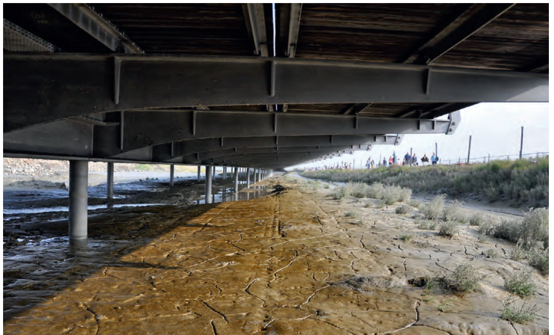
Untersicht mit den schlanken Rundstützen bei Ebbe. Rechts ist noch der alte Damm zu sehen. Foto: Isabella Marboe
