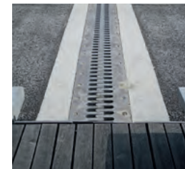
Dehnfuge zwischen den Brückenelementen, Lichtstrahler im Boden, Sitzbank Fotos: Isabella Marboe/SR
