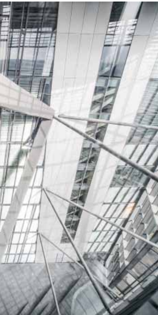
Blick aus dem 25. OG des Südturns ins Atrium auf die Umsteigeplattform im 15. OG, Haltepunkt der gläsernen Expressfahrstühle Fotos: EZB/Robert Metsch; Schnitt: © Coop Himmelb(l)au
