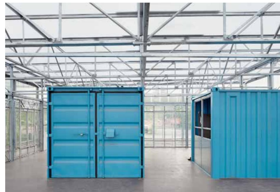
Die Bauhaus-Fenster wurden in eine neue Stahlkonstruktion montiert. Die Membrandecke, die zur Verschattung dient, ist noch nicht eingezogen. Als Nebenräume dienen Fracht-Container.
