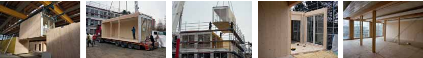
Einzel auf LKW haben die 98 Holzmodule die 630 Kilometer aus der Werkhalle in der Steiermark nach Frankfurt zurückgelegt, wo sie in dreieinhalb Wochen aufgestellt wurden. Die Stützen unter den Buchenholzträgern sind Transportsicherungen, die nach der Montage entfernt wurden. Foto links: Kaufmann Bausysteme
