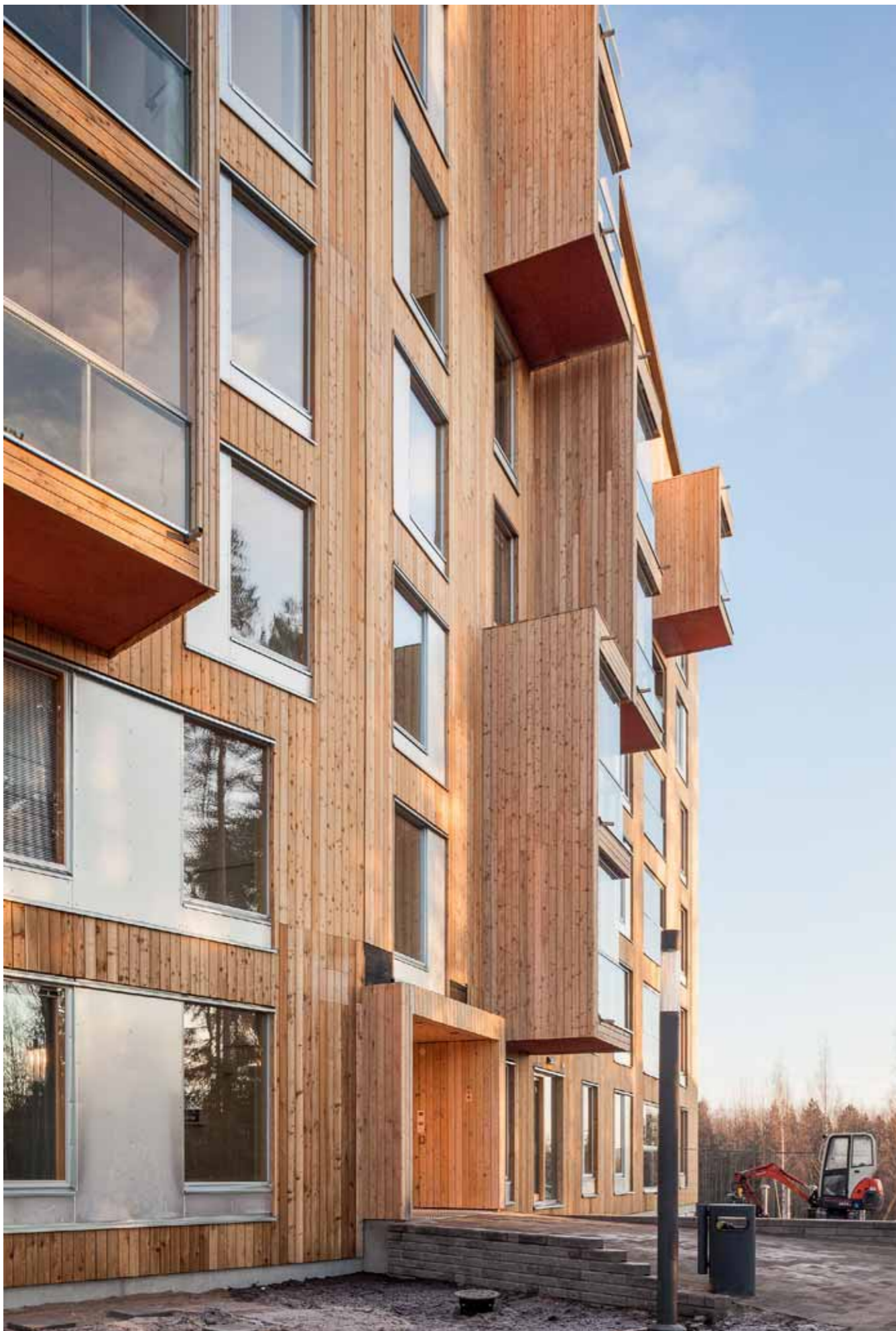
Die Gartenseite des Gebäudes ist von unbehandeltem Lärchenholz und den unregelmäßig angeordneten Loggien und Balkonen geprägt.
