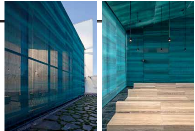
Ein Geflecht aus patinier- tem Kupfer verwehrt Einblicke in die Kapellen. Grundrisse Unterge- schoss, Erdgeschoss und Schnitt im Maßstab 1:500 Kleines Foto oben links: kuvio
