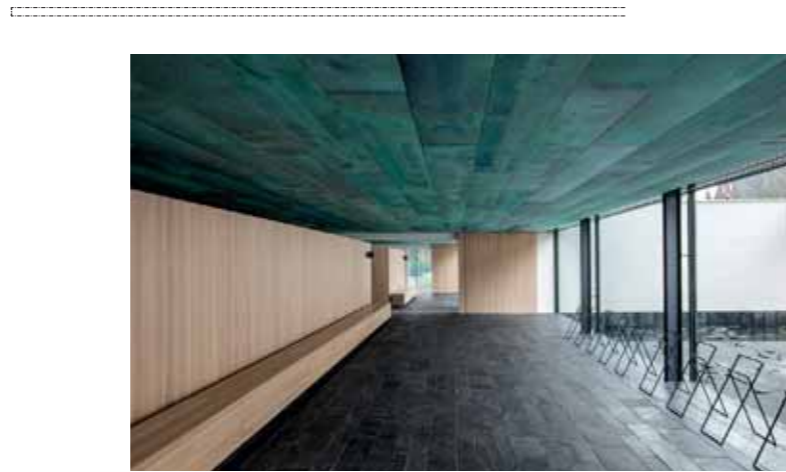
Kupfer, Holz, Schiefer, ge- schlemmtes Sichtmauer- werk: Die Materialien der Kapelle sind langlebig.
