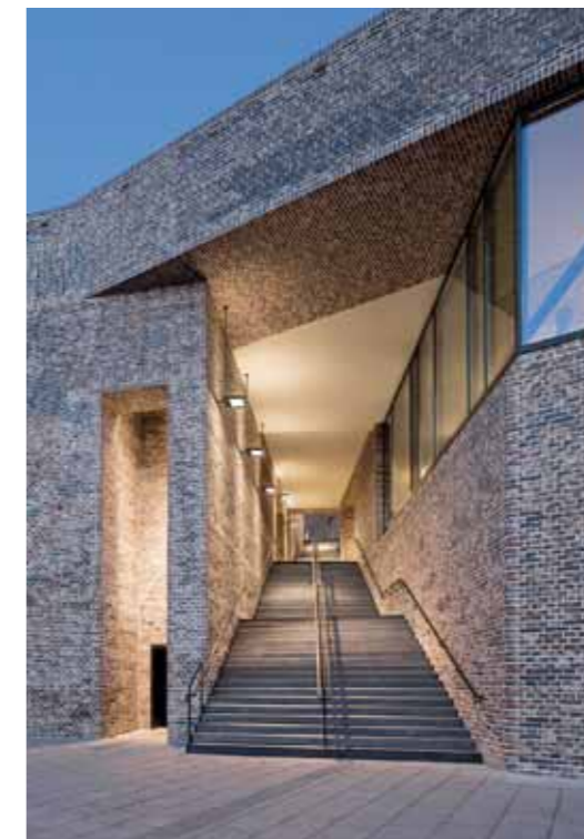
Die einläufige Treppe verbindet den Museumsneubau und die höher gelegenen, historischen Bauten des Burgklosters miteinander. Rechts: „Vierpass-Vorhang“ für den Giebel an der Straße „Klein Altefähre“
