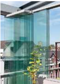
Seitliche Glasflächen zum allseitigen Verschließen des „Balkonzimmers“
