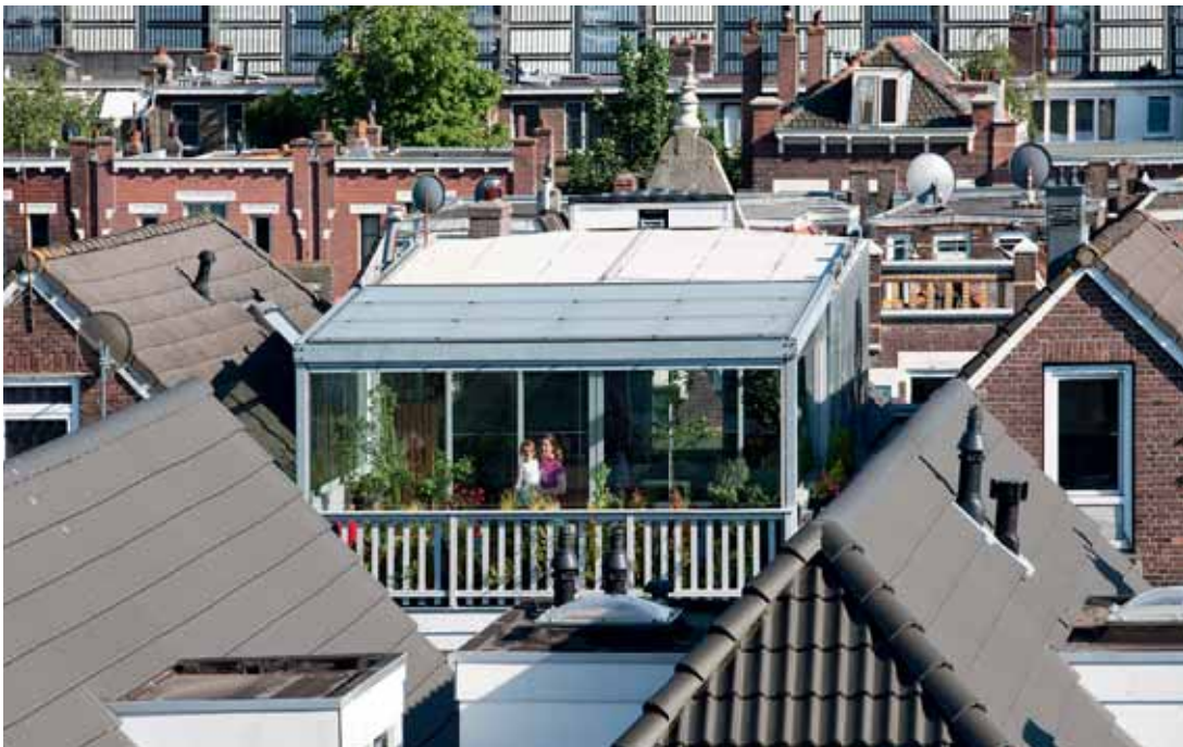
Die Dachterrasse in offenem und geschlossenem Zustand
