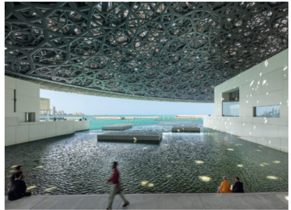
Hafenbecken zwischen den weißen Blöcken mit Freitreppen und Pontons in Erwartung der Besucherboote. Foto diese Seite: Das gegenüber liegende Becken. Links das Café, rechts der Saal für temporäre Ausstellungen mit dem großen Fenster des VIP-Bereichs. Der äußere Ring der Kuppel ruht auf vier Auflagern. Er besteht aus drei umlaufenden Trägern, die voll verschweißt wurden.
