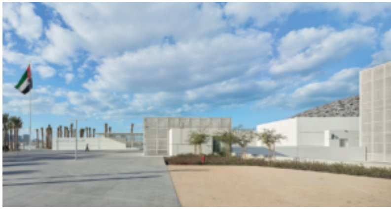
Der Eingang vom Parkplatz ist unscheinbar. Der Besucher erreicht über eine Passerelle den ersten weißen Block mit der Security-Schleuse. Rechts der Gitterrost-Block mit der Verwaltung. Unten: Eine der Zufahrten mit dem Boot nahe der Landseite.
