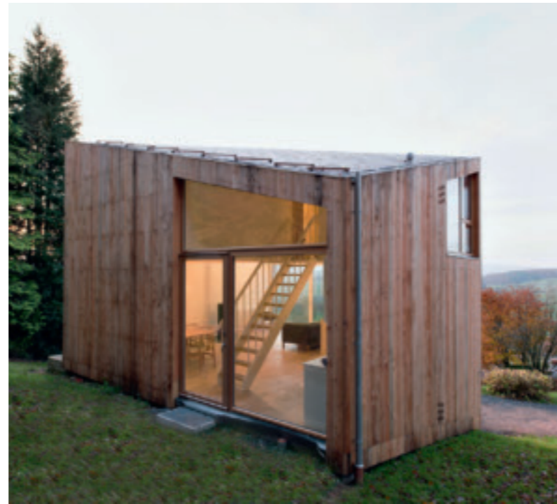
Der diagonale First hat das Volumen des Hauses vergrößert, sodass ein zusätzliches Dachgeschoss möglich wurde. Unten: Das Balkongeländer ist, neu verzinkt, erst zurückgekehrt, als der Fotograf weg war.
