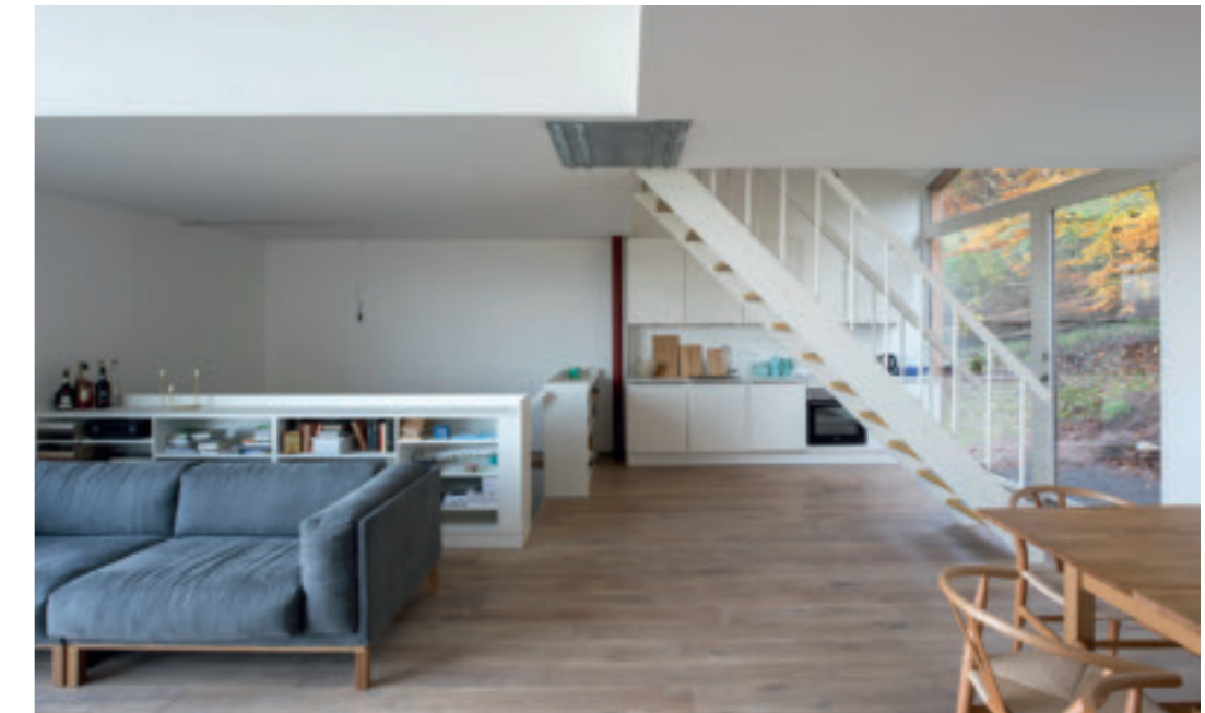
Im Obergeschoss mit dem Wohn-/Essbereich haben sich, jeweils an der Fassade, zwei Lufträume ergeben. Das mit 64 Schrauben verankerte Blech an der Decke verhindert das Klaffen der Fuge zwischen den beiden vom Dach abgehängten Schlafzimmern. Grundrisse und Schnitte im Maßstab 1:200
