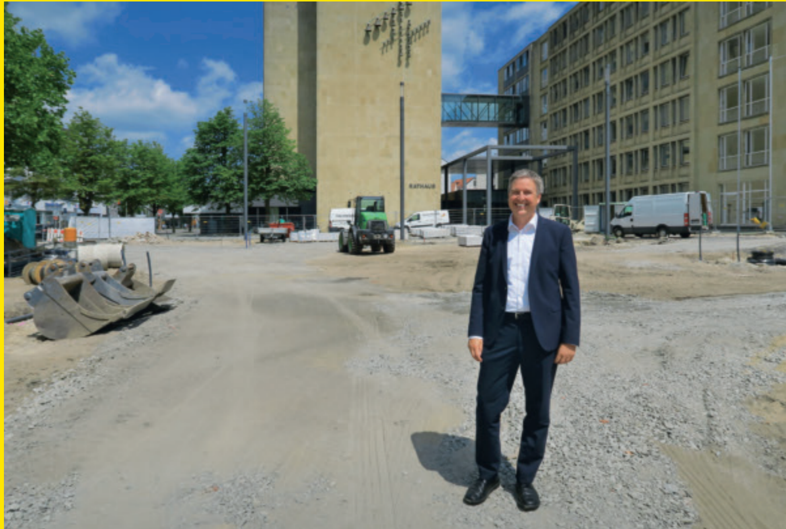
Auch die Hardware steht zur Debatte. Aus dem Dauer-Parkplatz wird ein Stadtplatz mit Fontäne: Henning Schulz auf der Baustelle vor dem Gütersloher Rathaus. Foto: Kaye Geipel
