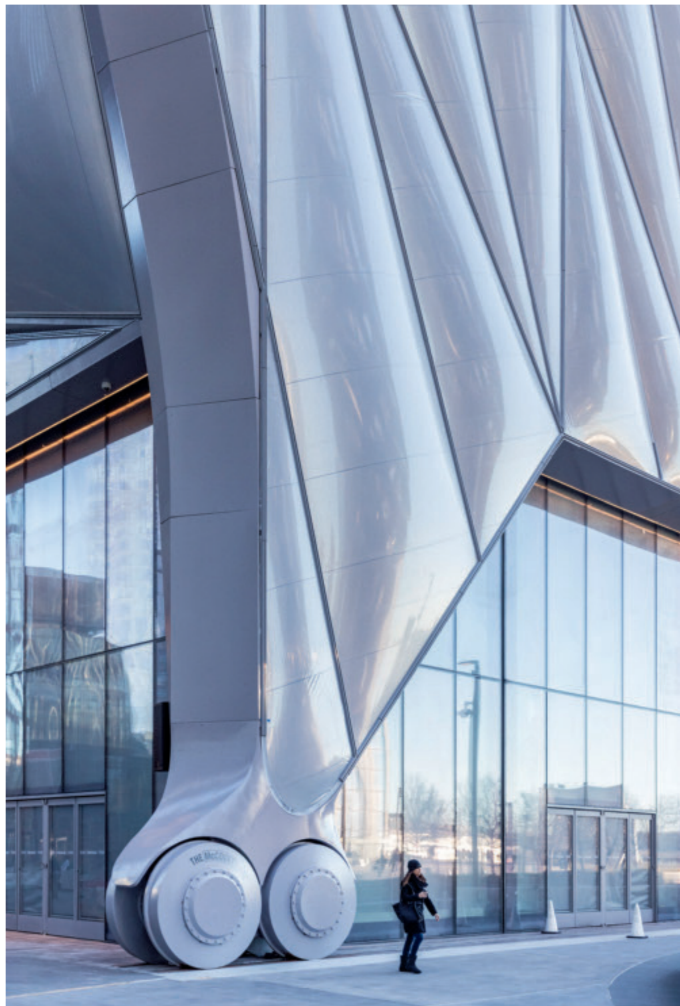
Auf einer 80 Meter langen Gleisstrecke rollt das Dach mithilfe der 6 sogenannten „Bogie Wheels“ vor und zurück. Foto: Ivan Baan
