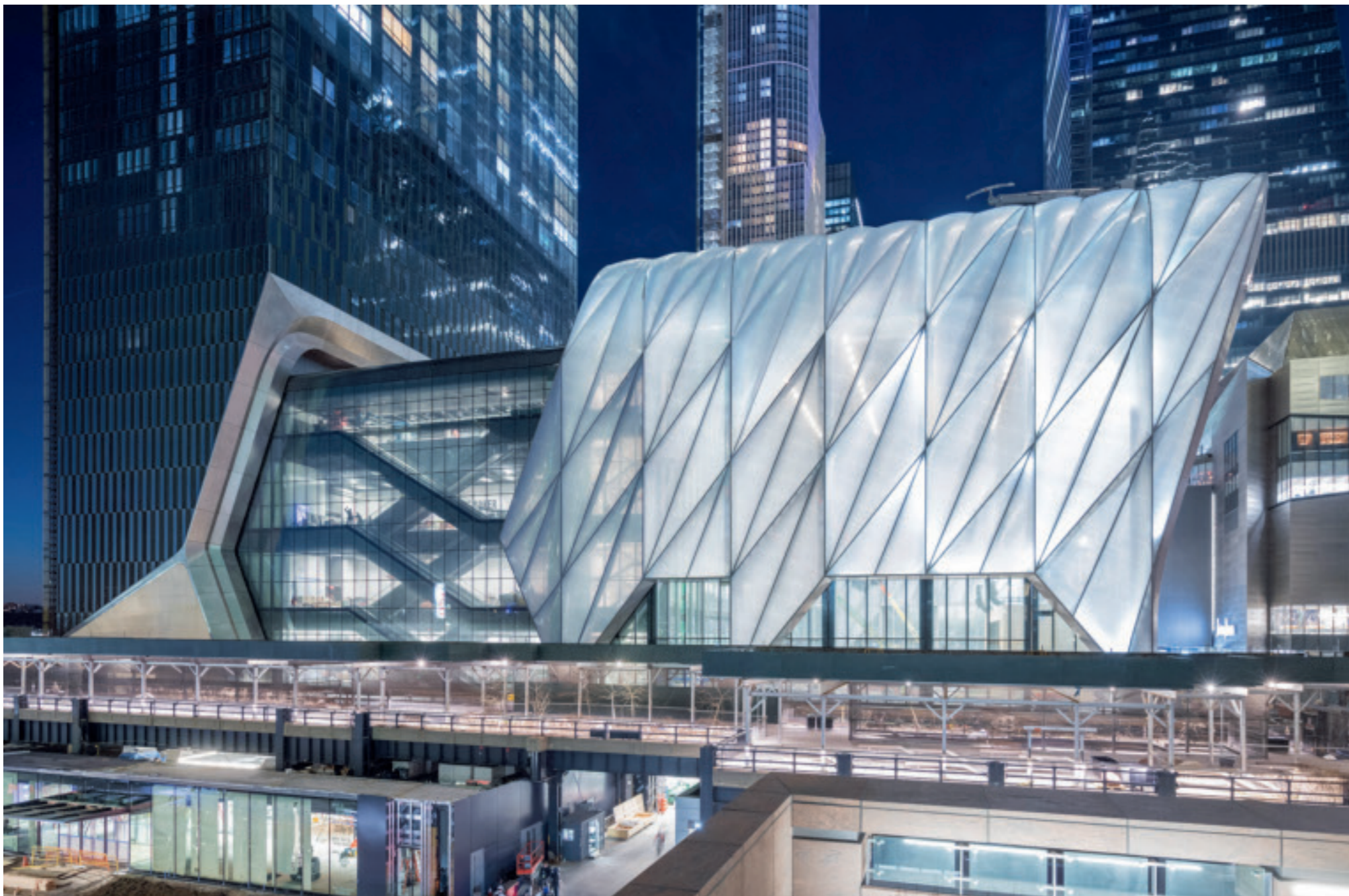
148 mit Luft gefüllte ETFE-Folienkissen spannen sich über das innenliegende Stahltragwerk. Fotos: Iwan Baan
