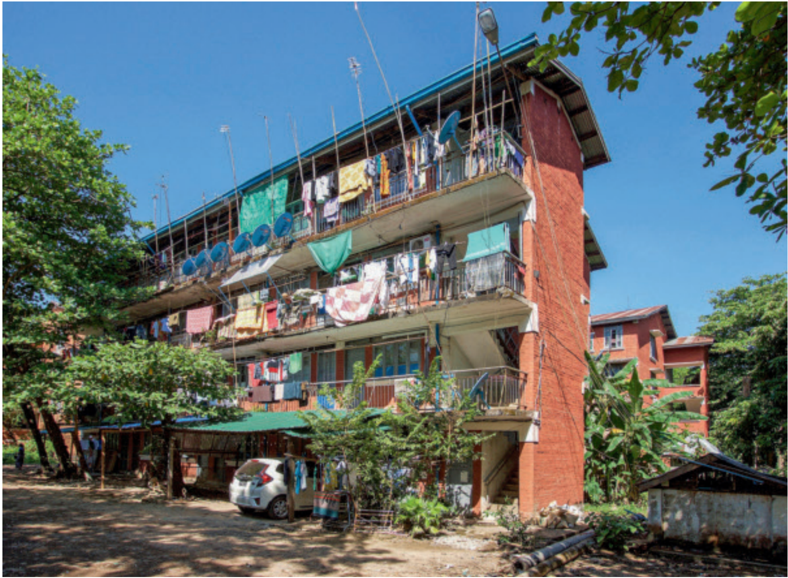
Einheimische Architekten führten eine neue Wohnungsbautypologie ein: Laubenganghäuser mit kleinen Wohnungen, erschlossen über offene Treppenhäuser an beiden Enden der Zeile
