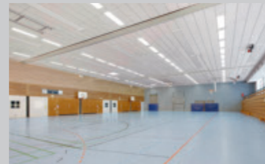
Im Zuge der Sanierung der 3-Feld-Sporthalle Travestraße in Bielefeld entschieden sich Stüwe Architekten für eine hochwirksame ballwurfsichere Akustikdecke, um eine gute Sprachverständlichkeit, hohe Schallabsorption und räumliche Pegelminderung sicherzustellen. Foto: HG Esch
