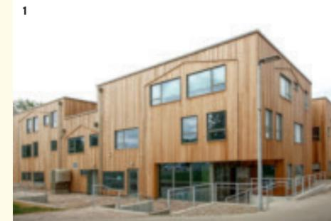
Die Kita und Erzieherfachschule in Wismar 1 ist ein Holzrahmenbau mit vorgefertigten Wandelementen 5, die mit einer Mineralwolle-Einblasdämmung maschinell befüllt werden 3.
