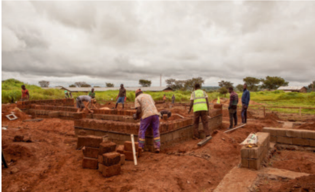
Baustelle des Gästehauses vom Krankenhaus in Ngaoubela in Kamerun. Foto: TUM DesignBuild
