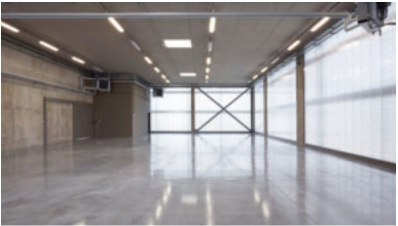
Im Lager kam eine Fassade aus Polycarbonat zum Einsatz. Unten die Werkhalle Fotos oben und unten: Margherita Caldi Inchingolo, rechts: Marco Cappelletti
