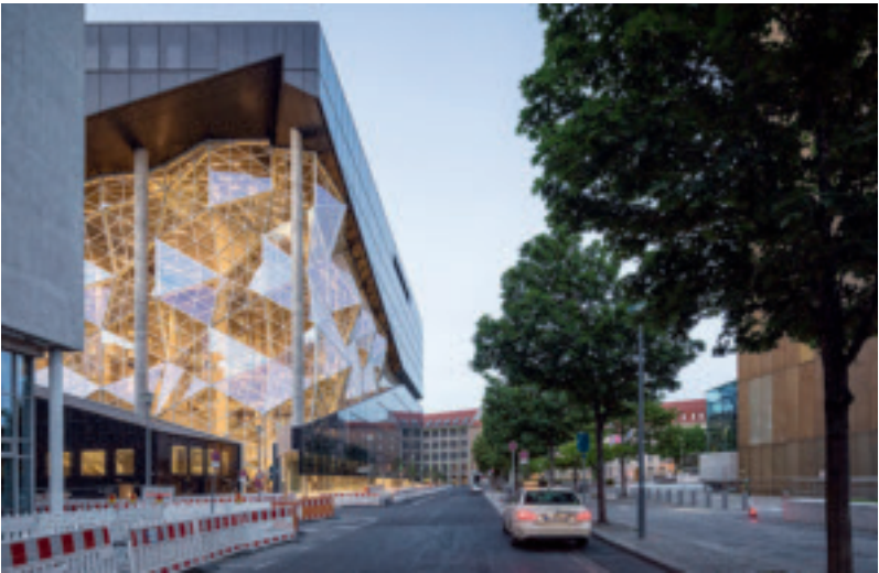
Oben: Blick in die Zimmerstraße. Unten: Die schwarzen, bedruckten Fassadenelemente sollen eine Reminiszenz an den Entwurf für das Glashochhaus (ca. 1922) von Mies van der Rohe in der Friedrichstraße sein.
