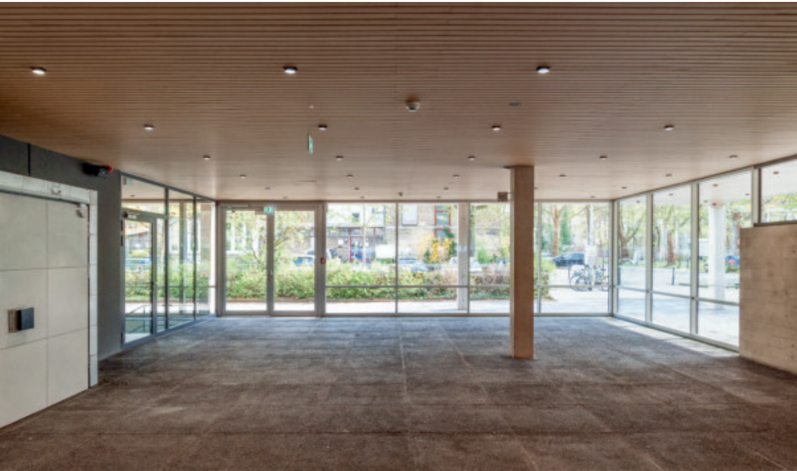
Im Foyer heute und früher: Die Leisten wurden ausgetauscht, LED-Punktleuchten angebracht und die Technik unter der Decke versteckt. Der Schnitt zeigt die übereinanderliegenden Hörsäle. Der untere Physikhörsaal wurde nicht saniert. Bild links: Heinrich Heidersberger (#885_21), TU Braunschweig, Audimax, 1960
