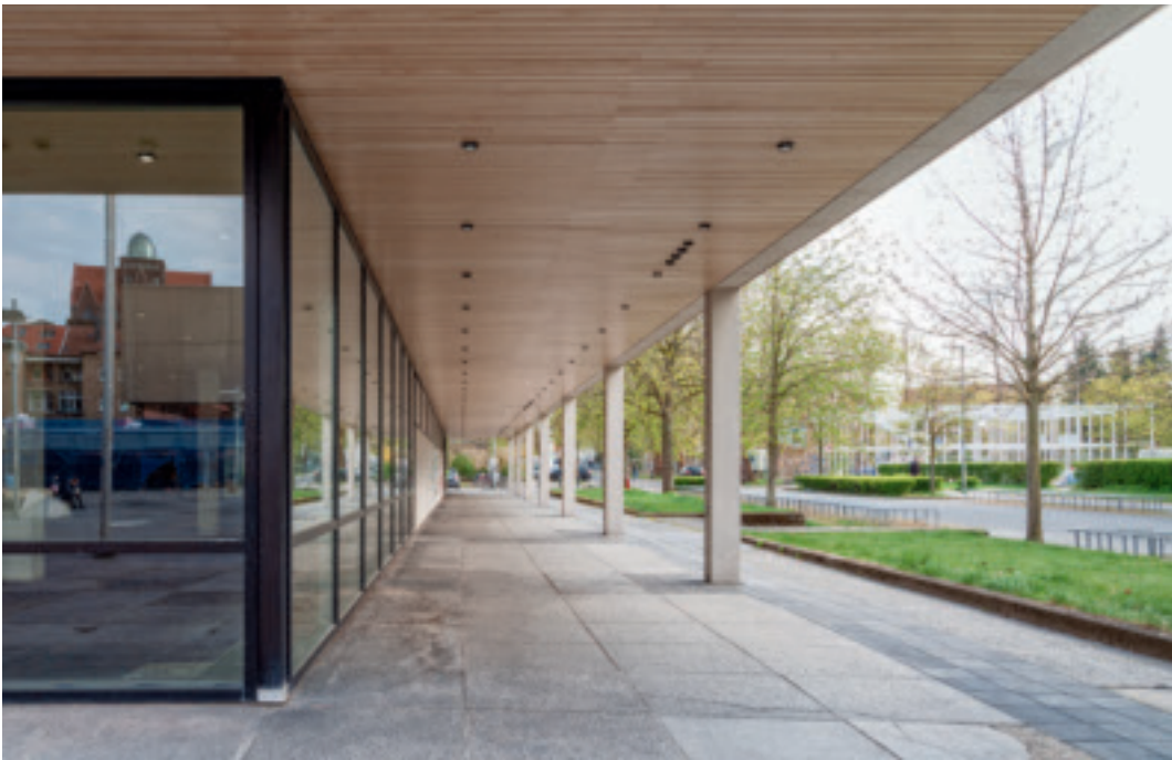
Blick entlang der sanierten Kolonnade. Außen konnten an der Decke die Leisten gegen neue Holzleisten getauscht werden, innen musste auf Kalziumsilikatleisten zurückgegriffen werden.
