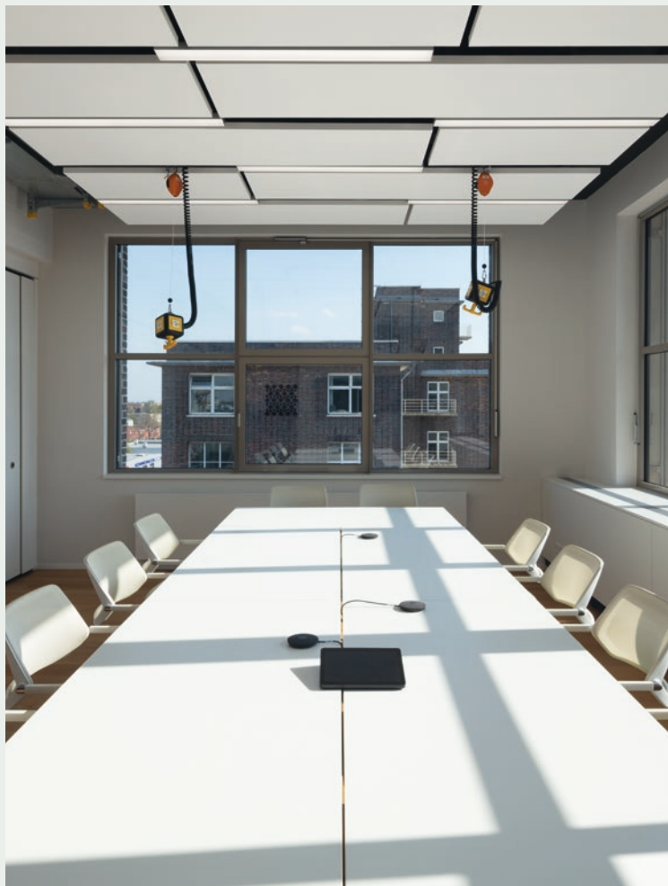
Die modulare Akustikdecke Solo Matrix von Ecophon hat beste Absorptionseigenschaften. Optisch nimmt sie sich zurück und unterstützt den architektonischen Charakter des Raums.
