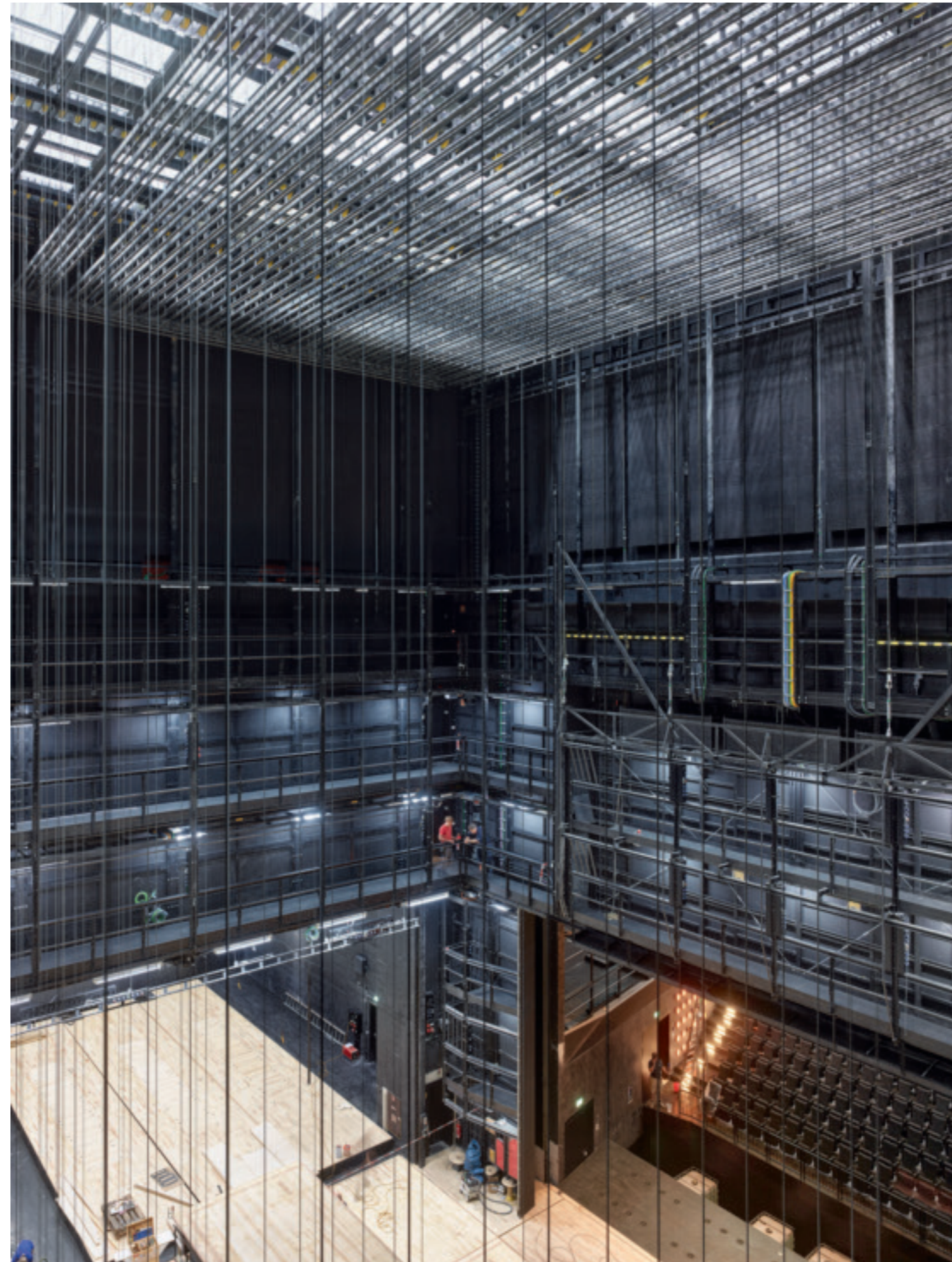
Der Bühnenturm misst innen 35 Meter Höhe, 17 Meter davon bohren sich in die Tiefe.
