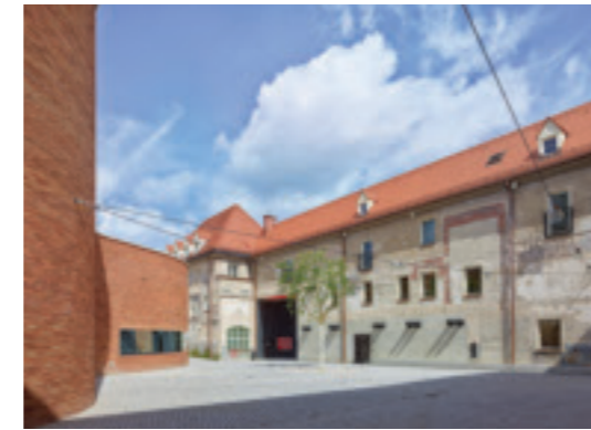
Die zum Hof weisende Putzfassade des Altbaus war einst eine Innenwand der angrenzenden Hallen. Grundrisse Erdgeschoss, 1. Obergeschoss und Schnitt im Maßstab 1:1000
