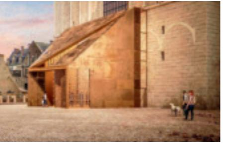
**Teilnehmer** Bernard Desmoulins gestaltet ein trichterförmiges Tor aus Aluminiumguss, das von transparenten Elementen und Löchern durchbrochen wird. Zwischen Außenhaut und Holzkassetten liegt eine Treppe.
