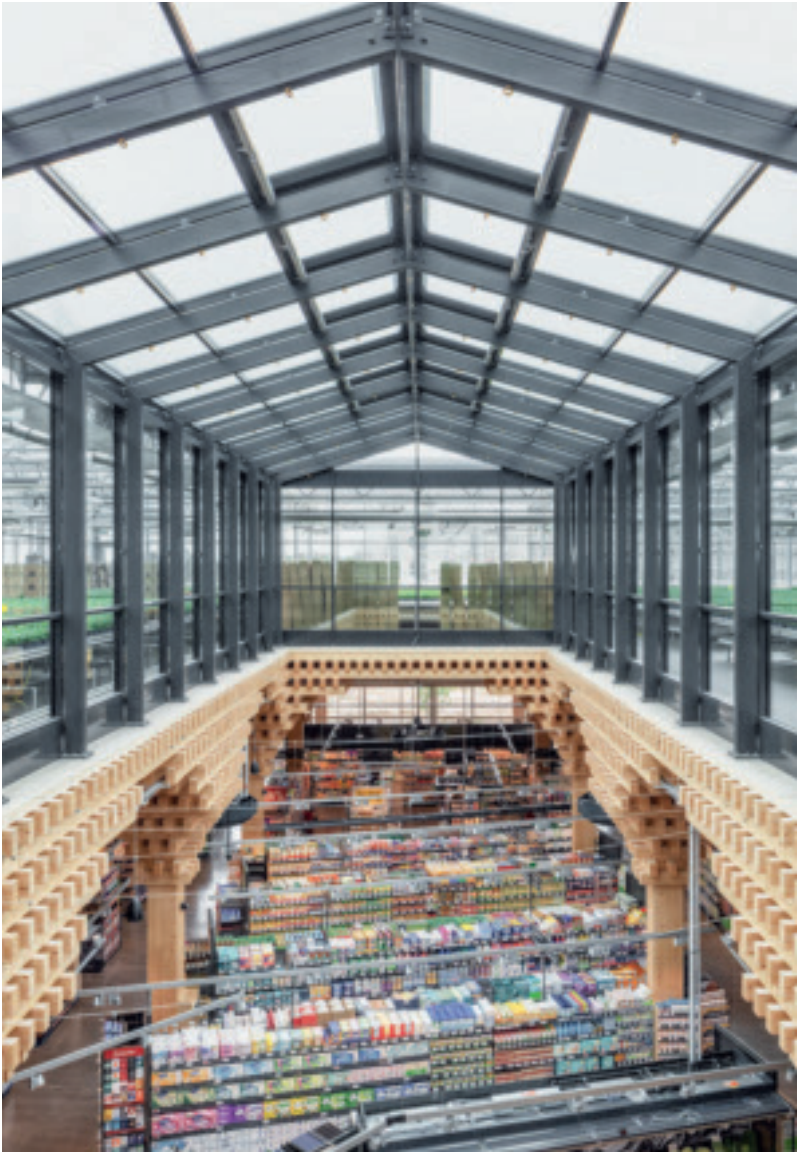
Das Gewächshaus auf dem Dach sammelt auch Kondenswasser. Den Supermarkt versorgt das Glasdach mit Tageslicht. Foto unten: hiepler, brunier
